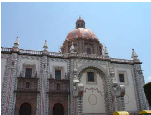
La iglesia está reforzada por unos contrafuertes muy particulares.
